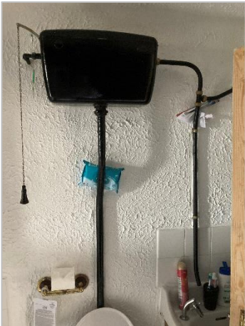
Photo 42 Original toilet cistern
